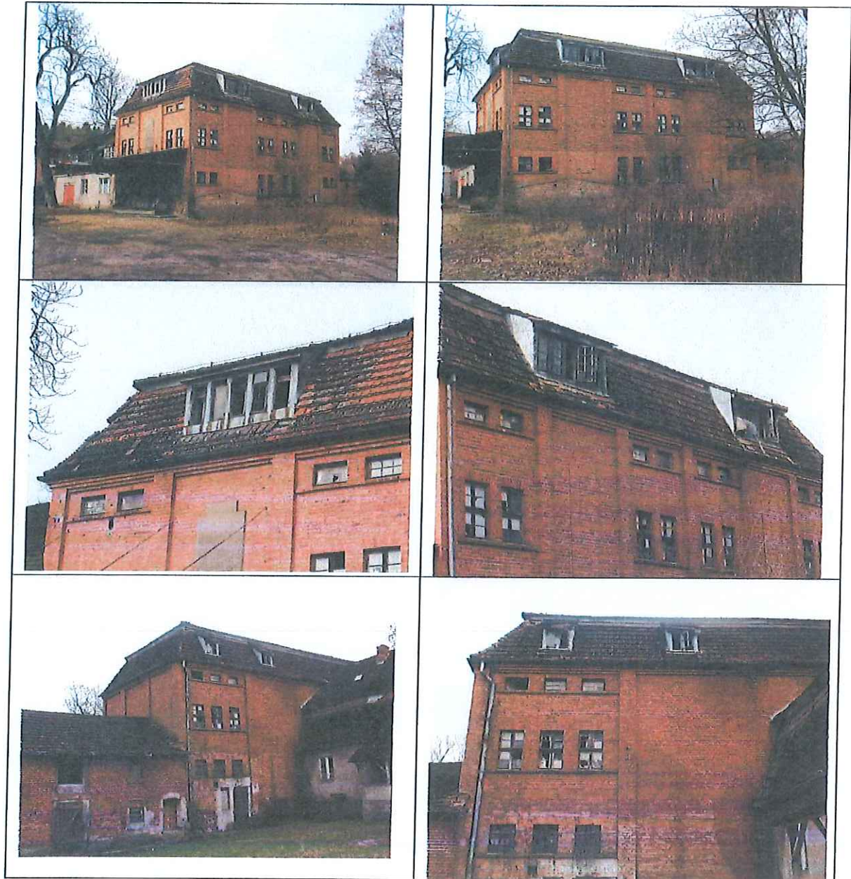
B/Wygląd zewnętrzny budynku po młynie
